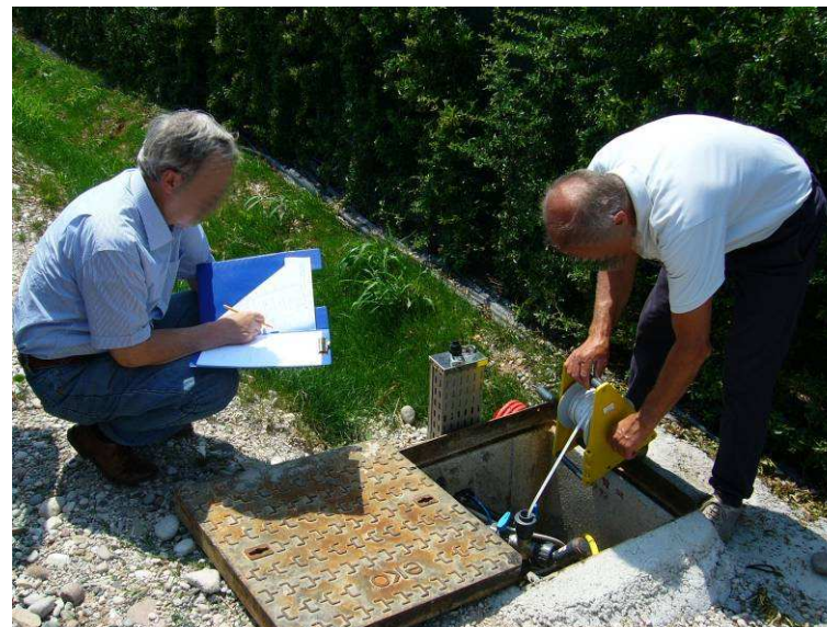
Fasi di misura del livello di falda nei pozzi-spia
