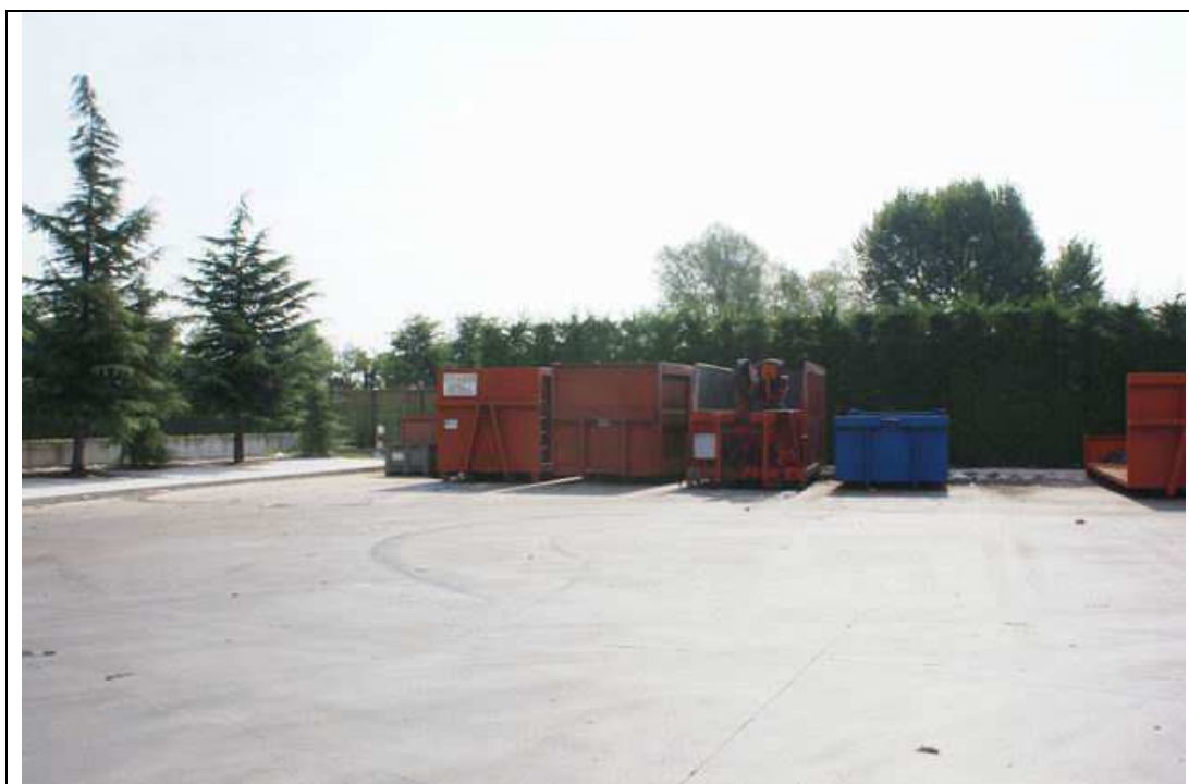
FOTO 3.2: Piazzale esterno, lato Nord, adibito allo stoccaggio dei containers vuoti. Sullo sfondo è possibile notare la barriera arborea, in corrispondenza della rete di recinzione perimetrale.
